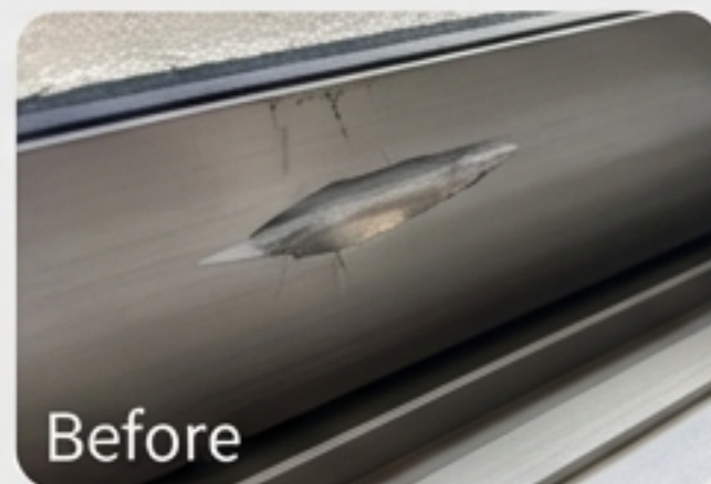
アルミサッシの傷補修
